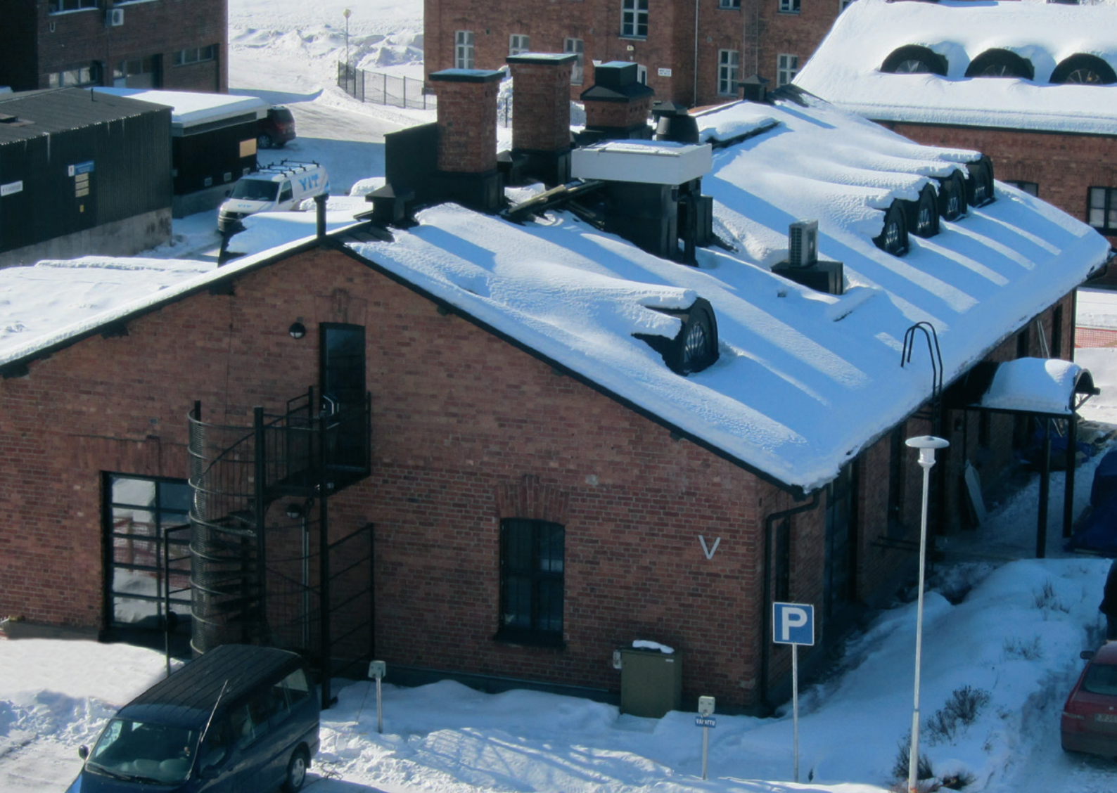
Mikkelin ammattikorkeakoulun hallintorakennuksen passiivijärjestelmä, jossa tuloilman esilämmitys ja jäähdytys on toteutettu vesikatolla sijaitsevalla ilmanottokatoksella. Passiivijärjestelmää hyödynnetään myös tutkimus- ja opetuskäytössä.
